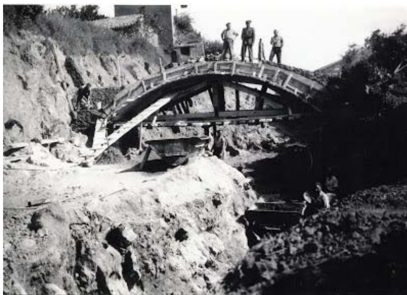
17.12. La Guardia Civil en labores de vigilancia de las obras del ferrocarril de Guernica (Vizcaya) que se inauguró el día 16 de agosto de 1955.
