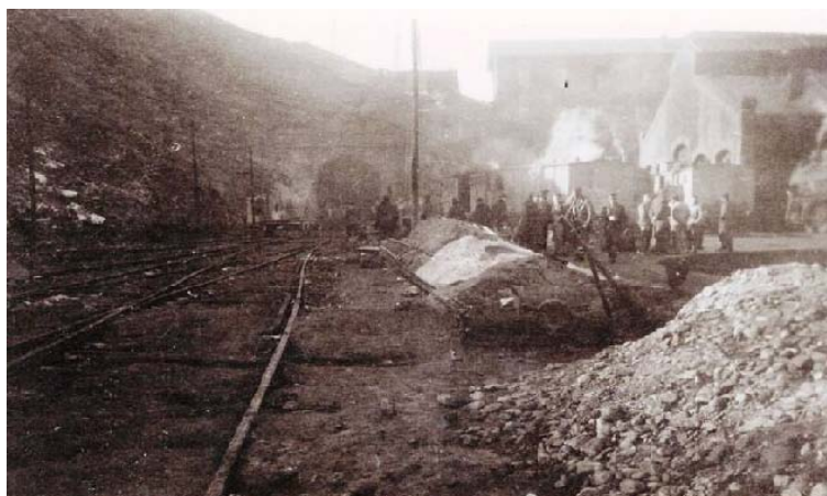
Túnel numero 20 humeante donde se produjo la tragedia, actualmente ya no existe, fue desmantelado entre 1985 y 1987
