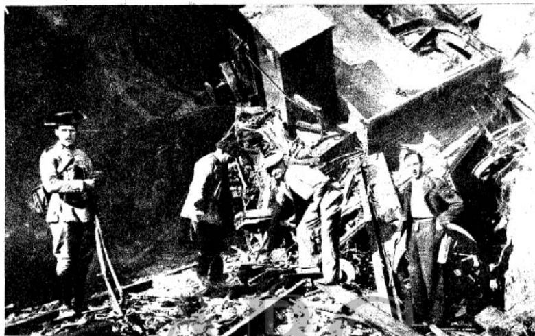
Un aspecto del estado en que quedó el tren de mercancías destruido a causa del derrumbamiento de una trinchera entre las estaciones de El Várcar y La Solana, cuando iba a entrar en un túnel. Quedaron los dieciocho vagones empotrados unos en otros, en un espacio de veinte metros, y hubo numerosas víctimas.
