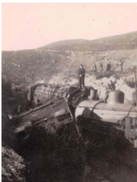
Locomotora del tren carbonero y máquina de maniobras, al otro lado del túnel, fotografiadas entre el 3 y el 6 de enero
